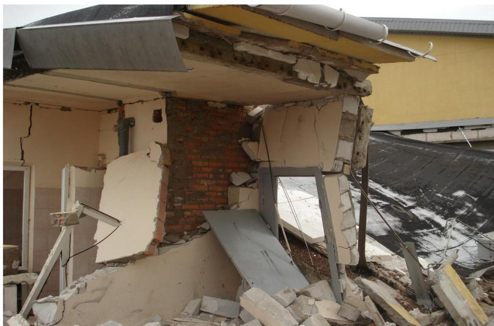
8). 26.03.2016 в мини-котельной (5x6 м) на территории филиала «Автобусный парк № 2» ОАО «Гомельоблавтотранс» (г. Мозырь, Гомельская область) произошел разрыв отопительного котла на твердом топливе. В результате разрыва котла произошло обрушение железобетонных плит перекрытия. Пострадавших нет. Предполагаемая причина разрыва – отсутствие циркуляции воды в системе.
