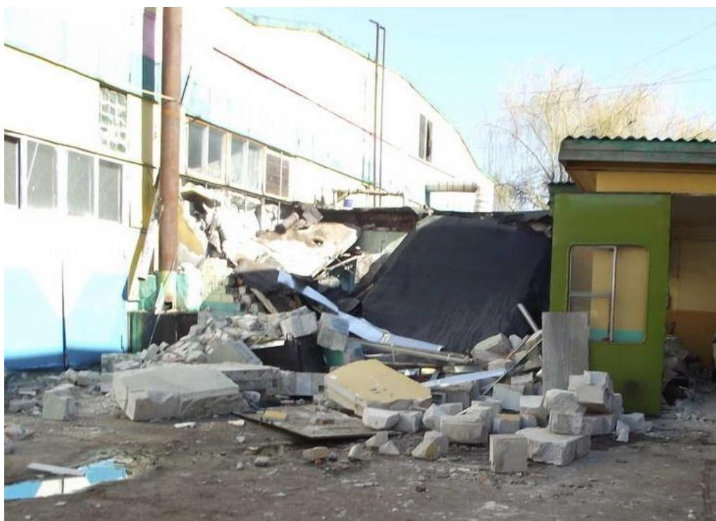
9). 27.03.2016 в мини-котельной (3х8 м), пристроенной к административно-бытовому корпусу ДКУСП «Глубокская ПМК-48» (ул. Озерная, 8, г.п. Подсвилье, Глубокский район, Витебская область) произошел разрыв отопительного котла на твердом топливе. В результате разрыв котла разрушено две стены в мини-котельной, повреждена кровля. Пострадавших нет. Предполагаемая причина разрыва – отсутствие циркуляции воды в системе.
