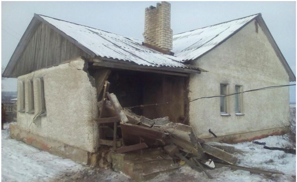
4). 07.01.2016 в помещении мини-котельной (3x3 м) жилого дома (ул. Бранцевича, г. Миоры, Витебская обл.) произошел разрыв отопительного котла. В результате разрыва котла разрушена стена топочной, повреждена кровля. Пострадавших нет. Причина разрыва котла – отсутствие циркуляции воды в системе.
